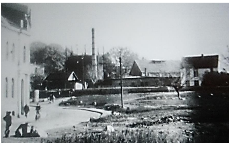
Widok rastenburskiej gazowni od strony ulicy Traugutta
