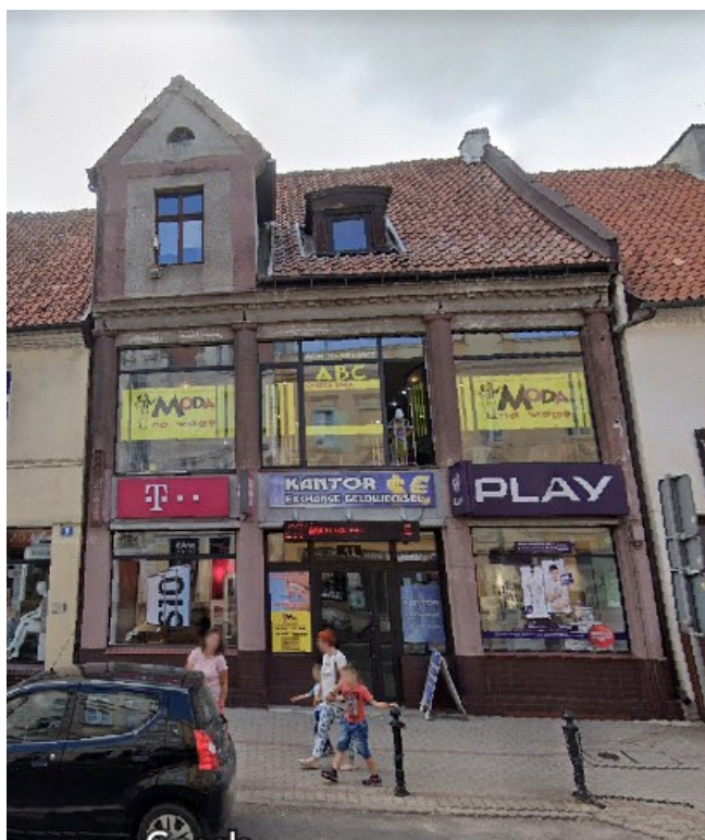
Obecny stan fasady sklepu Jacoby'ego i Solty'ego przy ul. Sikorskiego w Kętrzynie (Dom Handlowy „ABC”).
